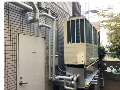
（ホテルマイステイズ上野イースト、高効率ヒートポンプ給湯機）
