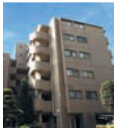
A14 アビタシオンクレール (大田区)
