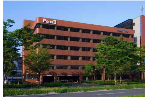
B12: 小倉興産17号館 (駐車場)
